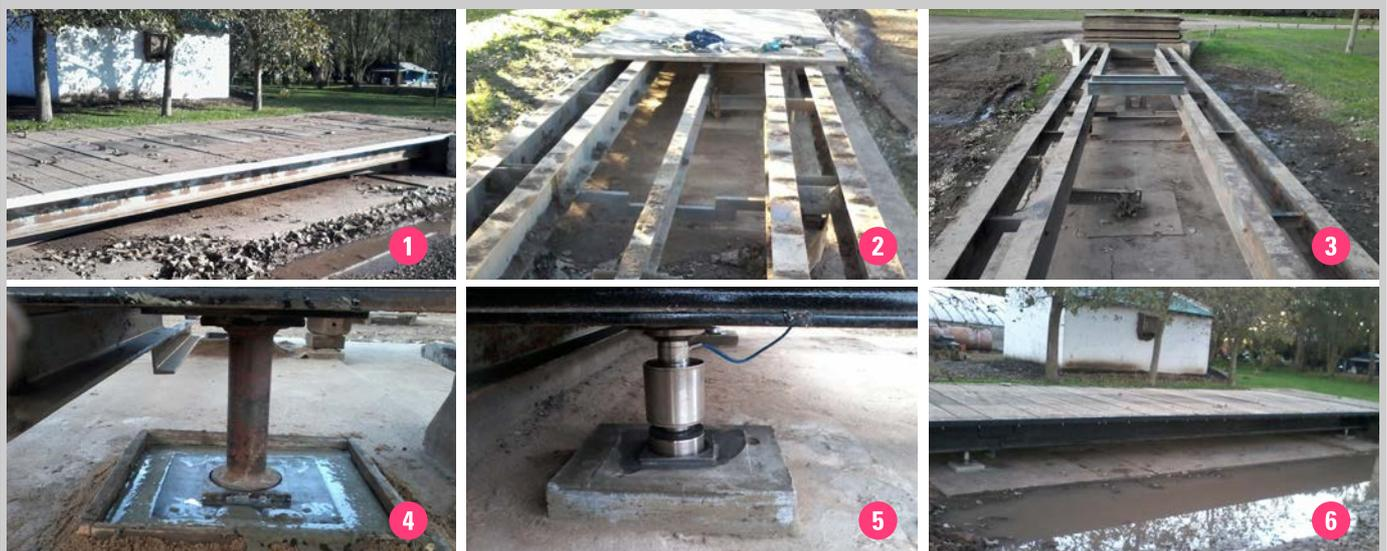
**1** Bascula mecánica en estado original / **2** Retiro del piso y desarme de la maquinaria mecánica / **3** Estructura sin maquinaria / **4** Preparación de los nuevos apoyos de la bascula / **5** Montaje de los sensores electrónicos / **6** Nueva bascula totalmente electrónica.
